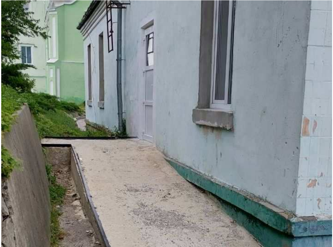
Рисунок Д.2.3 – Загальний вигляд вхідної групи та пандусу до будівлі бібліотеки. Горизонтальна площадка перед входом до будівлі бібліотеки
