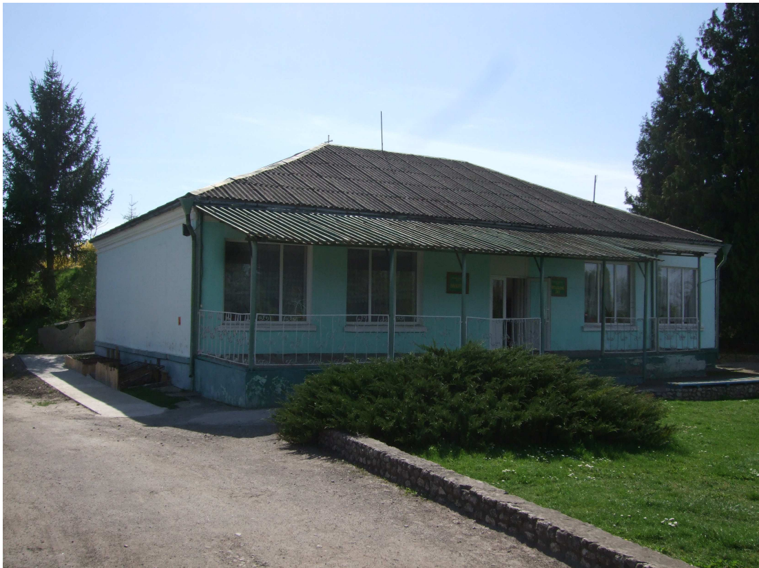
Рисунок Д.2.1 – Загальний вигляд будівлі бібліотеки, що знаходиться за адресою: вул. Молодіжна, буд. 1 в с. Білокриниця Кременецького району Тернопільської області
