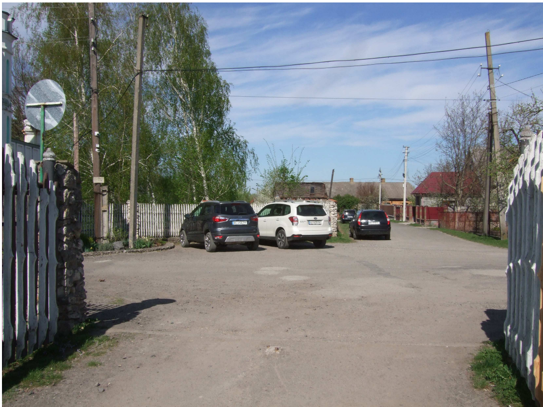
Рисунок Д.2.2 – Місця для паркування особистого автотранспорту осіб з інвалідністю або транспорту, який перевозить осіб з інвалідністю розміщені неподалік від входу до будівлі бібліотеки
