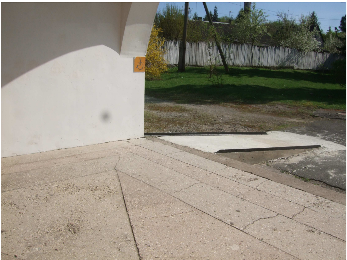
Рисунок Д.2.4 – Горизонтальна площадка перед входом до будівлі будинку культури
