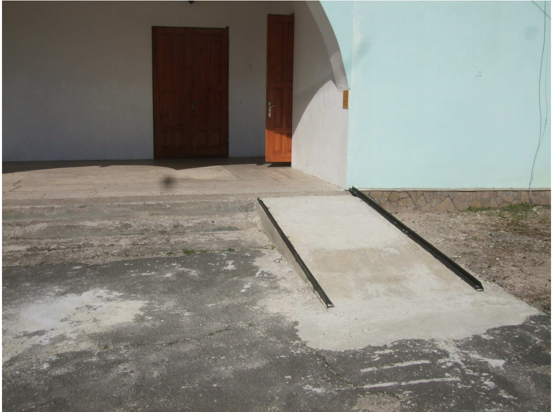
Рисунок Д.2.3 – Загальний вигляд вхідної групи та пандусу до будівлі будинку культури
