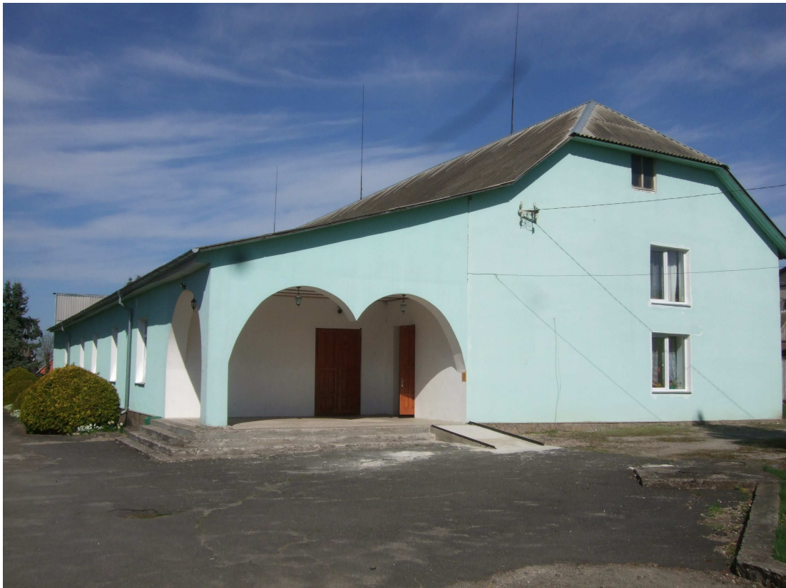
Рисунок Д.2.1 – Загальний вигляд будівлі будинку культури, що знаходиться за адресою: вул. Молодіжна, буд. 1 в с. Білокриниця Кременецького району Тернопільської області
