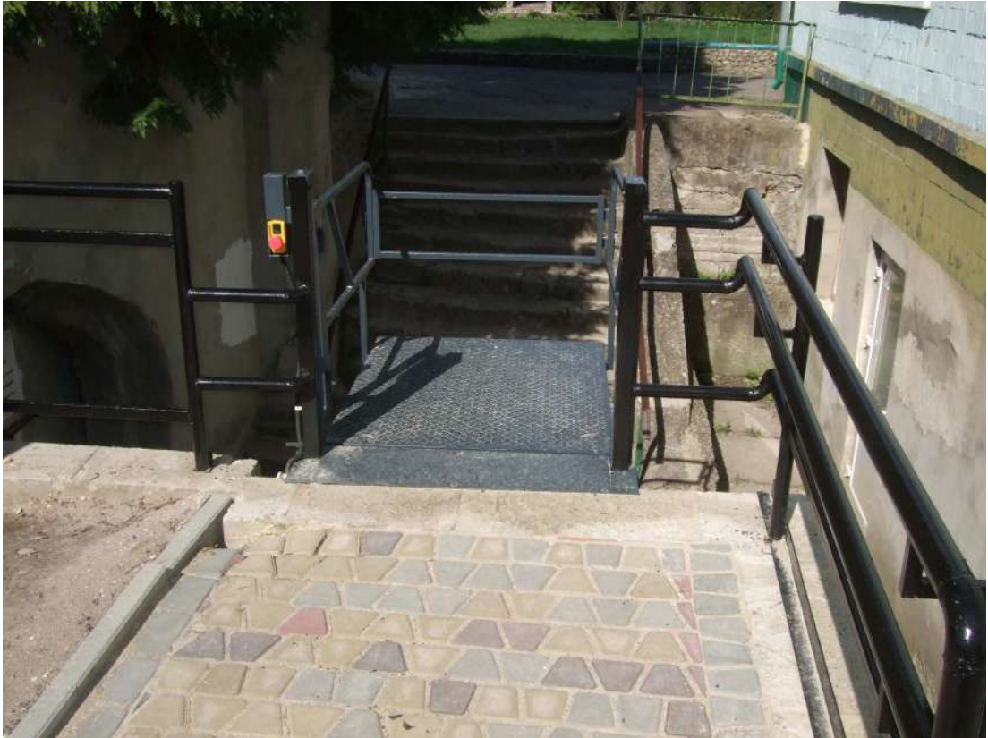
Рисунок Д.2.5 – Підймальна платформа UP-1 у верхньому робочому положенні
