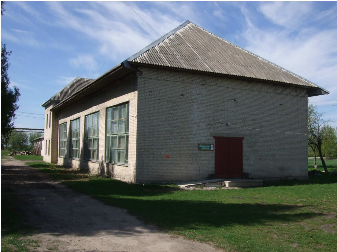
Рисунок Д.2.1 – Загальний вигляд будівлі деревообробної майстерні, що знаходиться за адресою: вул. Молодіжна, буд. 1 в с. Білокриниця Кременецького району Тернопільської області
