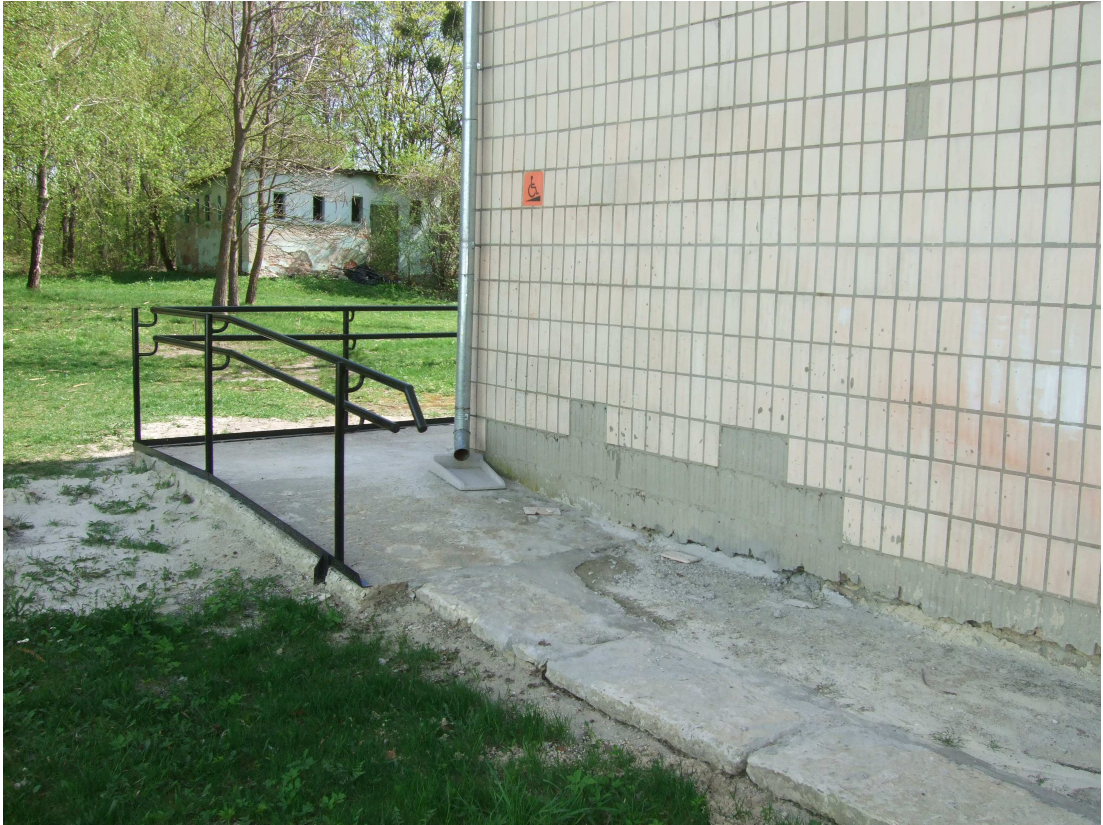
Рисунок Д.2.5 – Загальний вигляд пандусу та бетонного тротуару, що веде до нього
