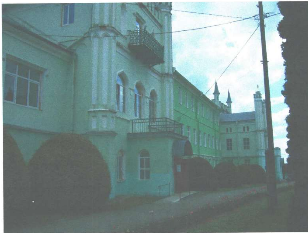
Рисунок Д.2.1 – Загальний вигляд пандусу на фасаді будівлі учбового корпусу №1 Кременецького лісотехнічного коледжу
