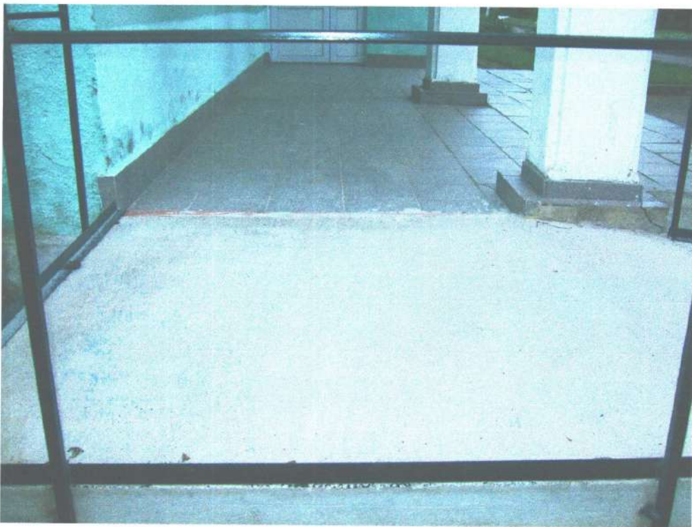
Рисунок Д.2.4 – Горизонтальна площадка пандусу, що знаходиться на рівні площадки входу до будівлі
