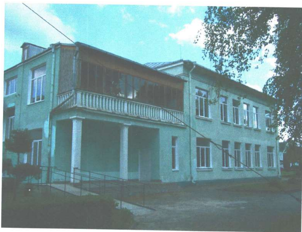
Рисунок Д.2.1 – Загальний вигляд пандусу на фасаді будівлі учбового корпусу №2 Кременецького лісотехнічного коледжу
